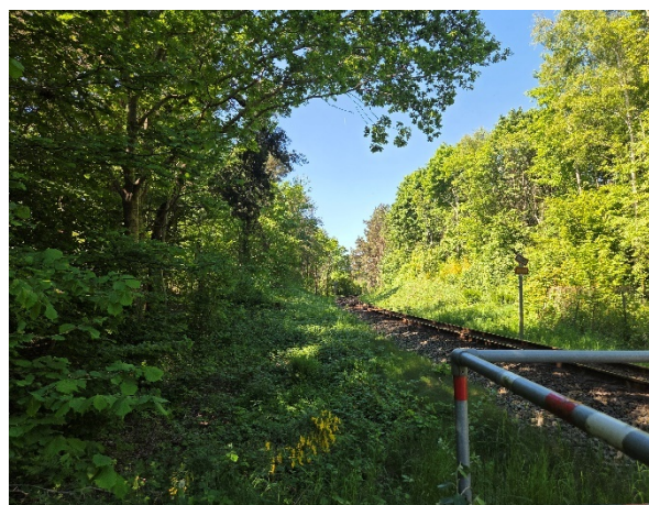
Lokalbanen som løber langs lokalplanens nordlige grænse. Ligeledes se overgangen og noget af skoven nord for lokalplanområdet
