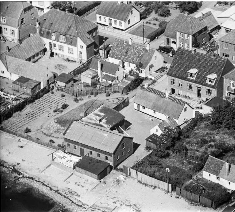
Luftfoto. Dette historiske foto (ukendt årstal) viser bygninger langs Nørregade øverst til højre og hvordan de vender ryggen mod havet og stranden nederst til venstre.
